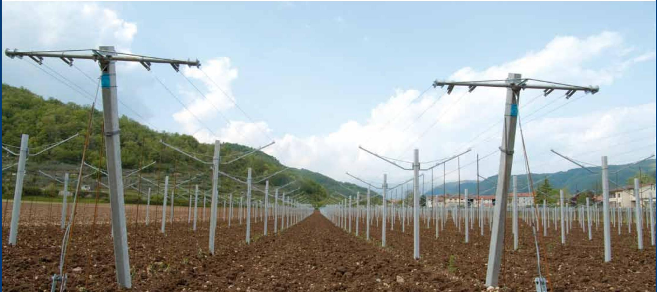
Comunemente chiamati braccetti, i sistemi di sostegno sono strutture metalliche costituite da acciaio profilato e trafilato che viene tagliato, sagomato e saldato a formare la struttura portante che, una volta montata sul palo, servirà da appoggio ai fili di sostegno delle piante. I braccetti studiati, progettati e testati dall'ufficio tecnico Valente, sono **frutto di una costante ricerca volta a migliorare i prodotti esistenti e a svilupparne di innovativi e di valore per il cliente.**
